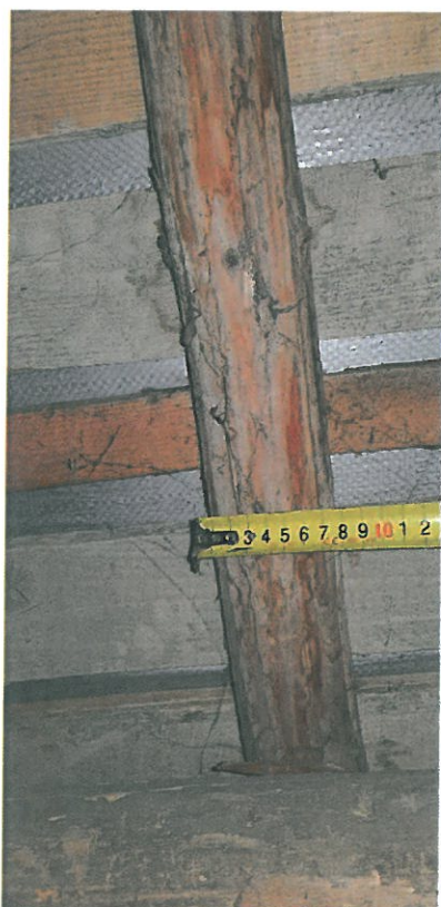
Evidentiere sectiuni caprior si pana lemn sarpanta
