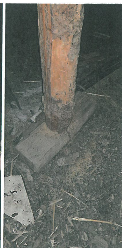
Talpa pop intermediar- lipsa mustati ancorare
