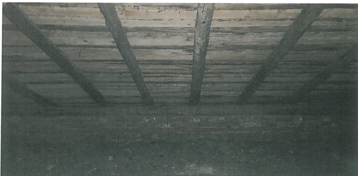
Vedere dispunere cosoroaba si mustati ancorare
